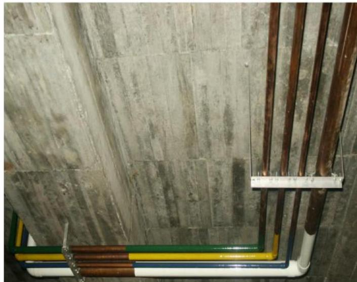
Su sistema comprende una red principal subdividido en ramales que van a diferentes áreas, permitiendo una mejor distribución de presión en el sistema el cual trabajaría presiones entre 50 a 60 psi y permitiendo disminuir los diámetros de tubería en los ramales secundarios según la cantidad de puntos a alimentar.
