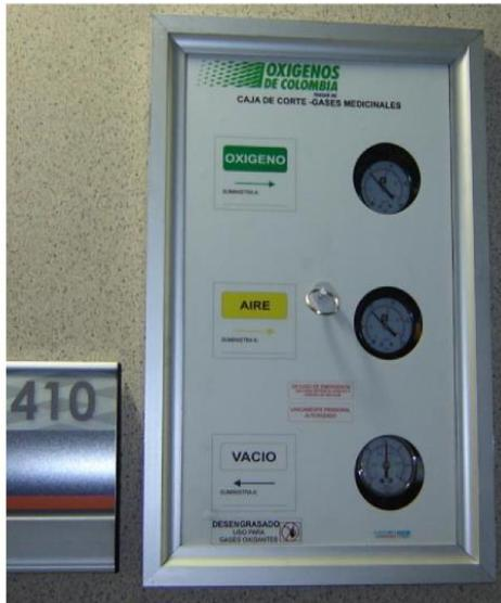
Estas se encuentran dentro de cajas metálicas provistas de ventanillas removibles que posean la suficiente amplitud para permitir la operación manual de las válvulas. En este proyecto las encontraremos para el manejo de uno (Sencilla), dos (Doble), tres (Triple) y cuatro gases con señal de vacío (Cuádruple), estas se ubicarán en sitios visibles, fuera de la zona que controla el suministro y ubicadas en la pared.
